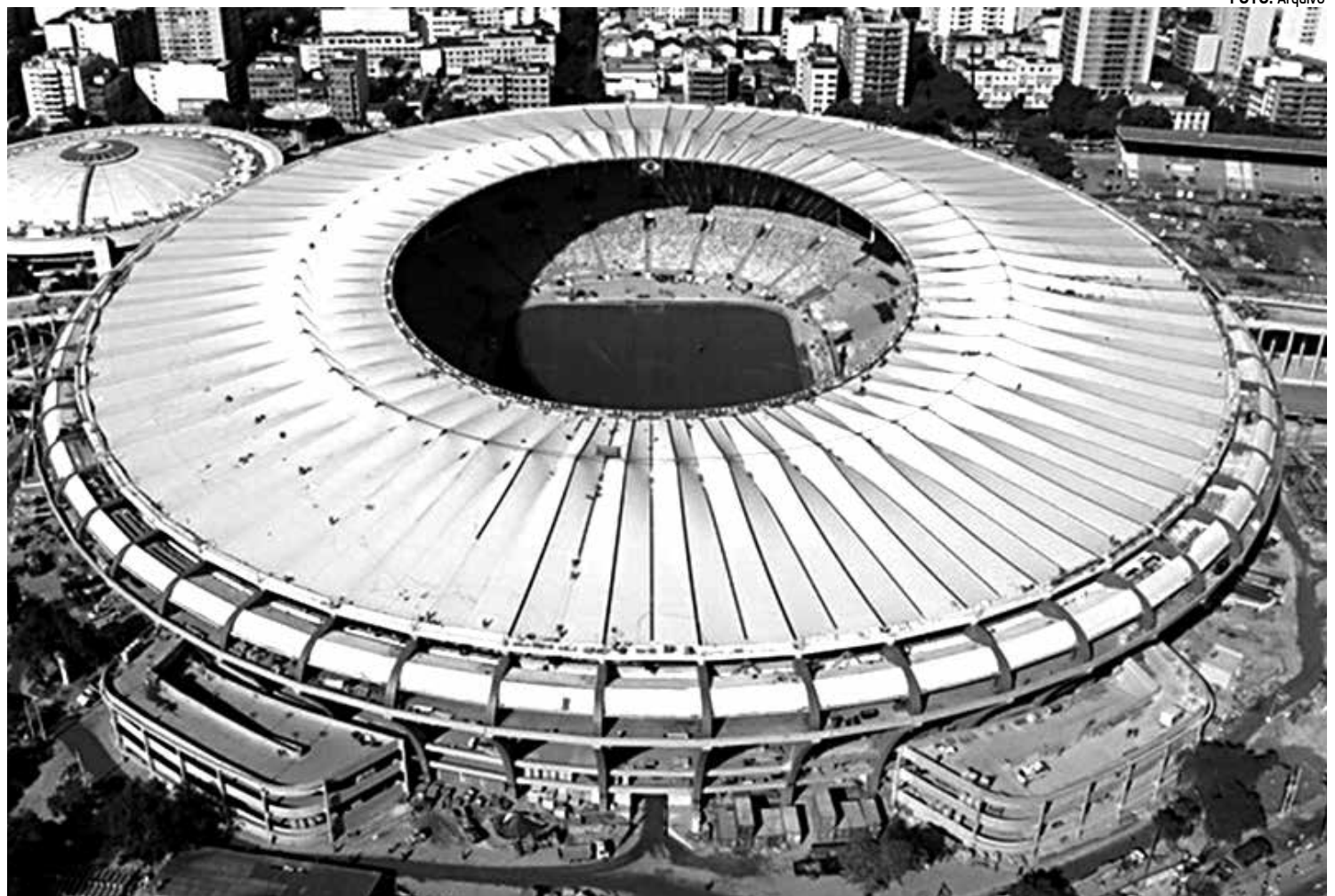
Na reforma do estádio do Maracanã (foto), a redução de gastos chegou a R$ 97 milhões; na Arena Amazonas, foi de R$ 65 milhões
